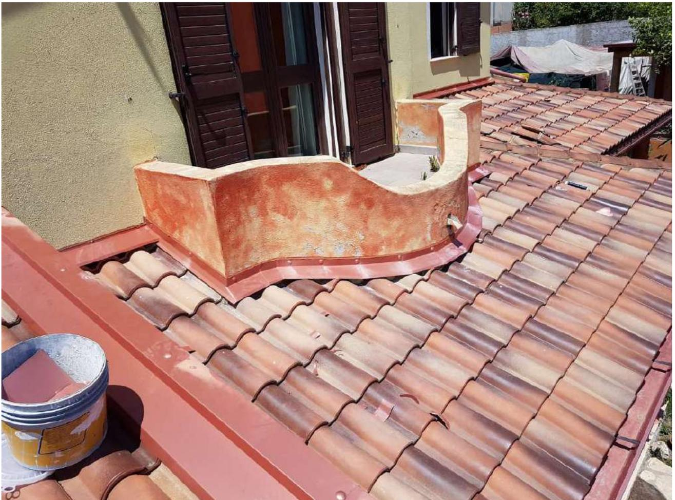
Scossaline rivestimento cornicioni, con piega centrale di abbellimento in alluminio color rame
