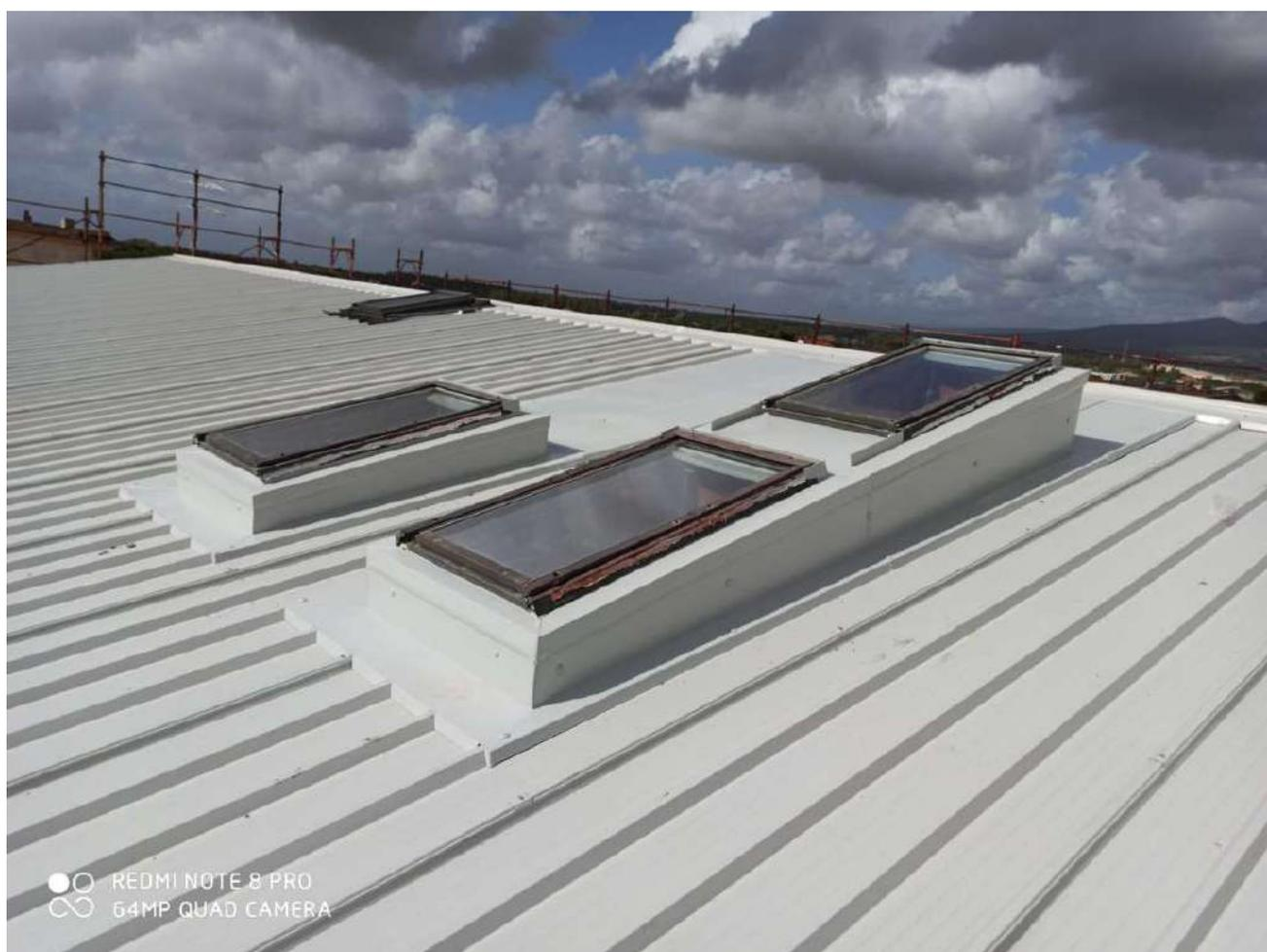
Scossaline con realizzazione di raccolta acqua a canale interno con beccucci di scarico in alluminio Bianco 9010
