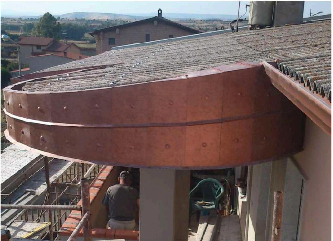
Scossalina alluminio roof con piega centrale e lavorazione in testata con sagomatura del profilo di gronda
